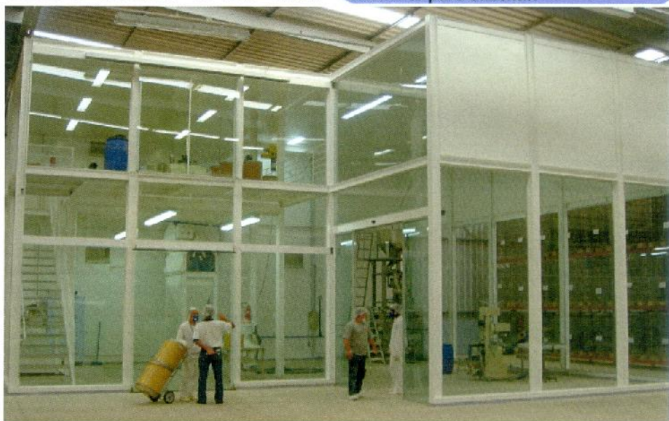
Fábrica Química Real
